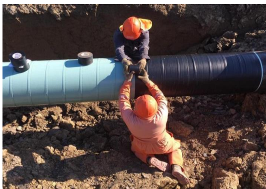
Slika. 5: Aplikacija sustava za zaštitu od korozije [3]
